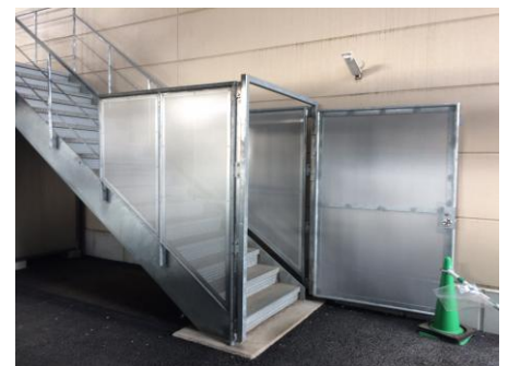
非常階段の出入口（1階）
