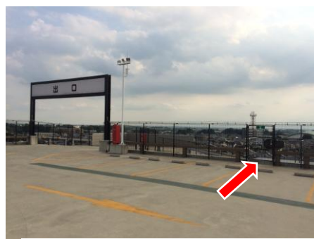
非常階段の出入口（屋上）
